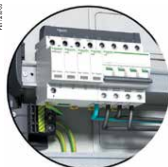
Ограничитель перенапряжения iPRD 3P+N + iC60N 3P+N
